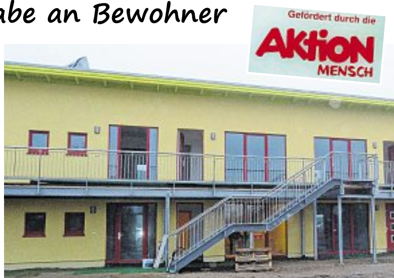
August-Seidel-Straße (Eingang - Hofseite)
